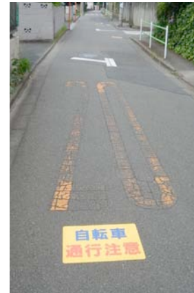
路面シール貼付
