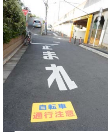
路面シール貼付
