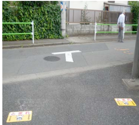
路面シール貼付
