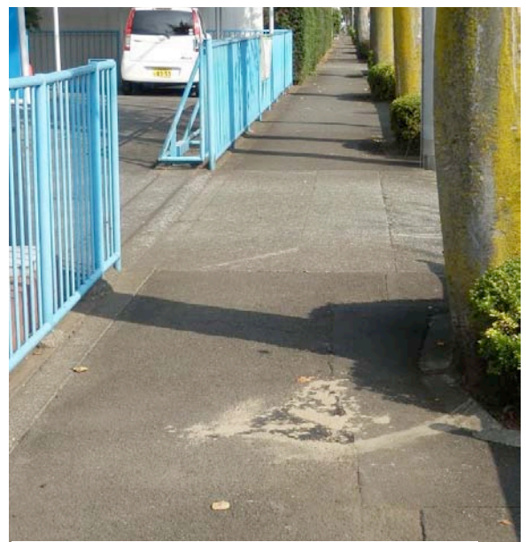
日吉町歩道の穴<補修完了>
